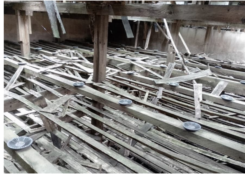
Detail oberste Lage Dreikanteleisten + Prallscheibe inkl. Tragbalken
