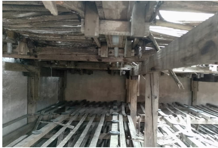
Detail oberste Lage Dreikanteleisten + Prallscheibe inkl. Tragbalken
